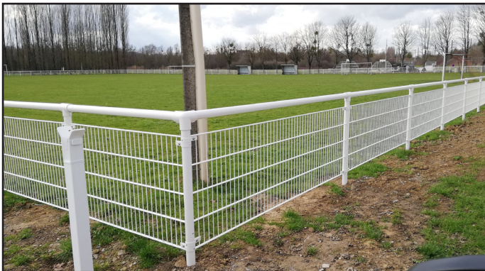
Installation d'une main courante au stade Jean-Pierre Frérot
