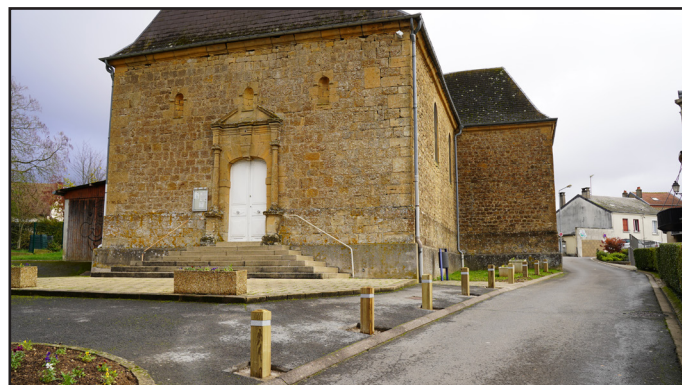
Poteaux rue de l'Eglise
