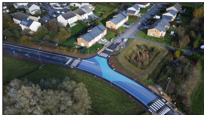
Travaux RD 33 : phase 1
