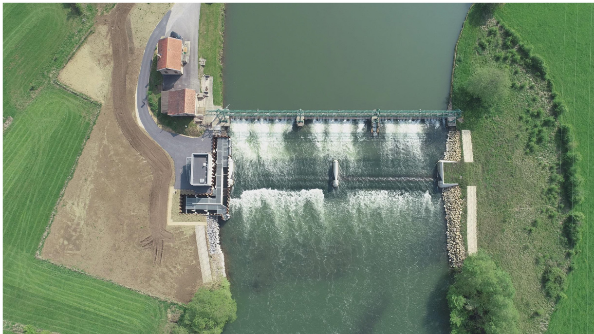
Le barrage automatique de Romery. Crédit photo Capteur Studio
